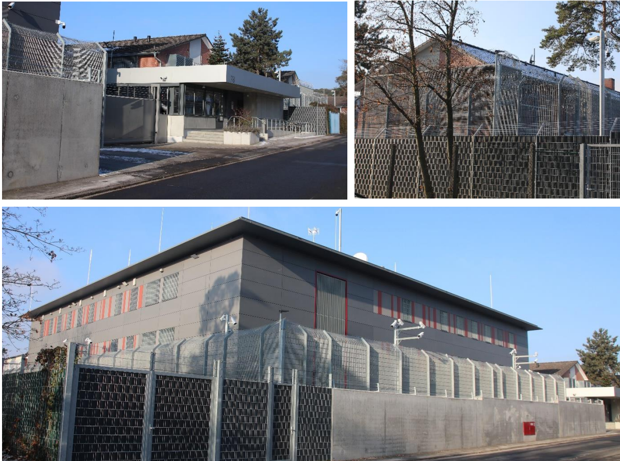
Abbildung 13 Drei der vier Gebäude des hessischen Abschiebegefängnisses sind abgebildet. Oben links: In der Mitte des Bildes ist die Pforte in Haus 3 zu sehen. Durch verspiegelte Scheiben, eine schwere automatische Tür und Sicherheitskontrollen wird der Eingang des Abschiebegefängnisses häufig als abschreckend empfunden. Links im Bild ist der Rand des Neubaus, Haus 4, zu erkennen. Rechts der Pforte lässt sich Haus 2 erahnen. Oben rechts: Die derzeitige Quarantänestation und das frühere Hauptunterbringungsgebäude, Haus 2, ist zu sehen. Dieses ist durch einen Zaun mit Stacheldraht zur Straße hin sowie einem weiteren haushohen Zaun mit Natodraht um das gesamte Gebäude herum gesichert. Unten: Der Neubau, Haus 4, ist zu sehen. Rechts im Bild ist die Pforte erkennbar.
